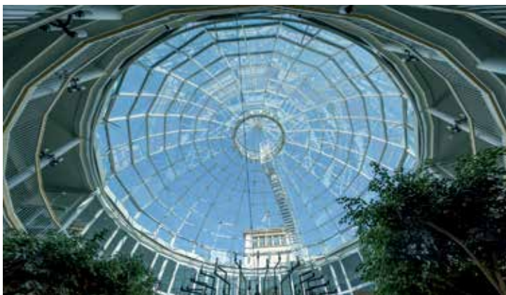
Das imposante Glasdach der Eingangshalle.
